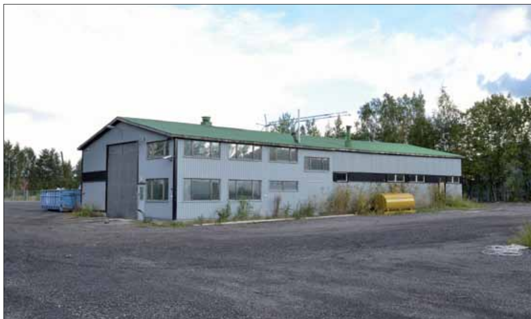
Vuodenvaihteen jälkeen tämä alue Tattarisuon Jäähdytintieellä näyttää varsin erilaiselta, kun siitä tulee noin 80 kuljettajan ja 40 bussin tukikohta uusine rakennuksineen.
